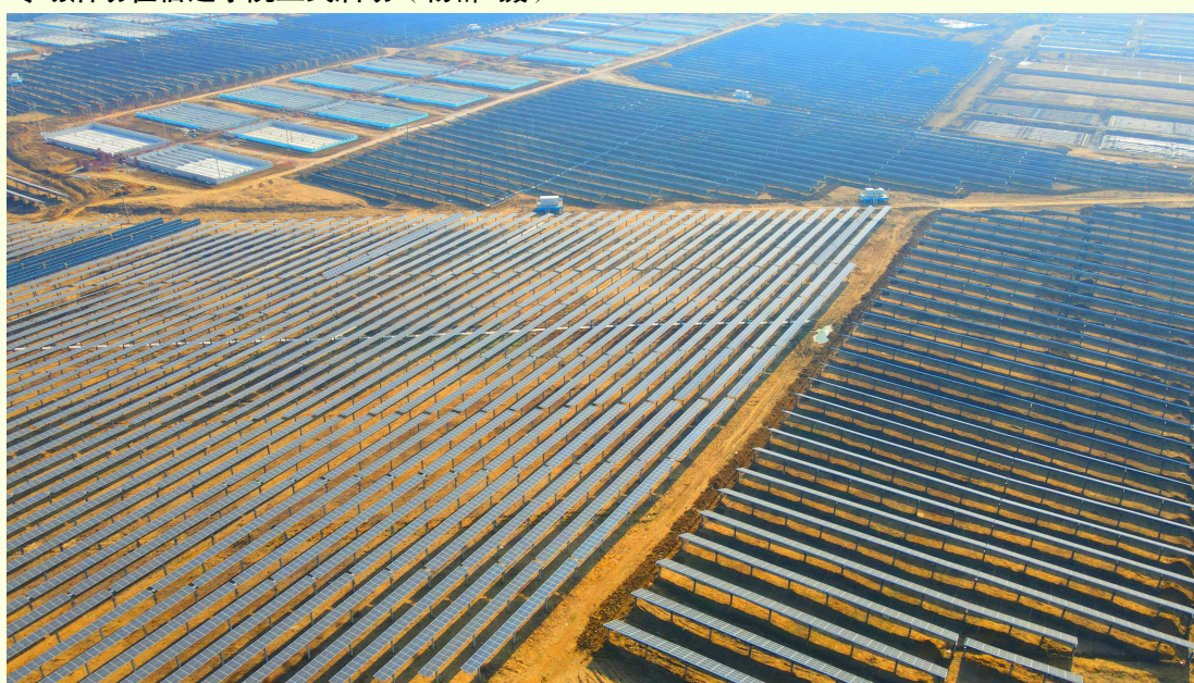
泗洪光伏发电领跑奖励激励基地，由三峡新能源、中广核林洋新能源、华能集团、国家电投集团分别建设5个规模100MW的光伏电站，年发电量约6.5亿度。基地采用“农（渔）光互补”开发模式，“板上可发电，板下可种植、养殖”，实现土地的综合利用，形成“农、光、渔”多产业融合发展格局。图为11月24日，泗洪县双沟镇高套村，2000多亩太阳能光伏发电板整齐排列（杨群 摄）
